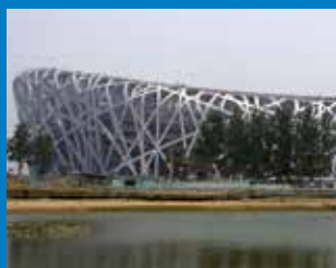
Stadion Olimpijski „Ptasie gniazdo”, Pekin – Chiny: system izolacji płynnej na powierzchni 25 000 m 2 dla trybun, parkingów i tarasów (2008)
