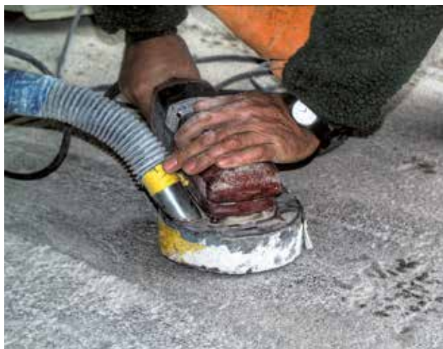
Ręczna obróbka z użyciem niewielkiej szlifierki rotacyjnej
