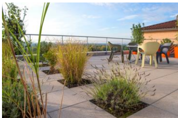
Fot 2. Zastosowanie systemu SOPRADALLE CREA (z elementami nasadzeń) na tarasie użytkowym wraz z płytami
