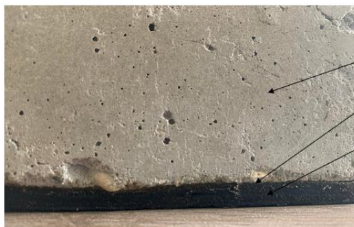
Rysunek 1 Połączenie między membraną COLPHENE® BSW a betonem.
